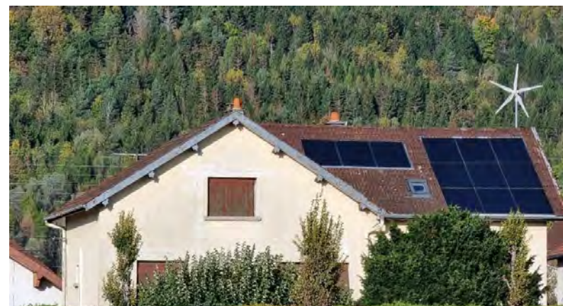
PANNEAUX SOLAIRES THERMIQUES SUR TOITURE DE MAISON INDIVIDUELLE A CHAMPAGNOLE, EVEN CONSEIL 2022
