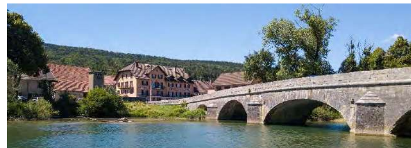
FIGURE 8 : PONT-DU-NAVoy VU DEPUIS L'AIN
