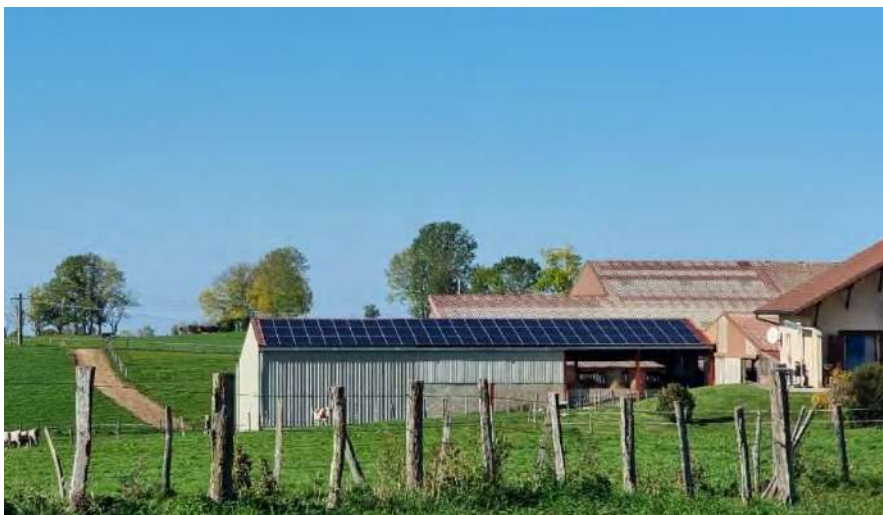
PANNEAUX PHOTOVOLTAÏQUES SUR TOITURE AGRICOLE A BIEF-DES-MAISONS, EVEN CONSEIL 2022
