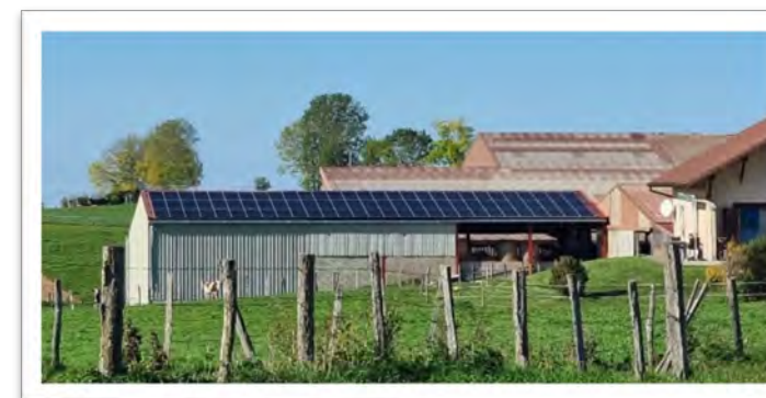
Panneaux photovoltaïques sur toiture agricole à Bief-des-Maisons.
